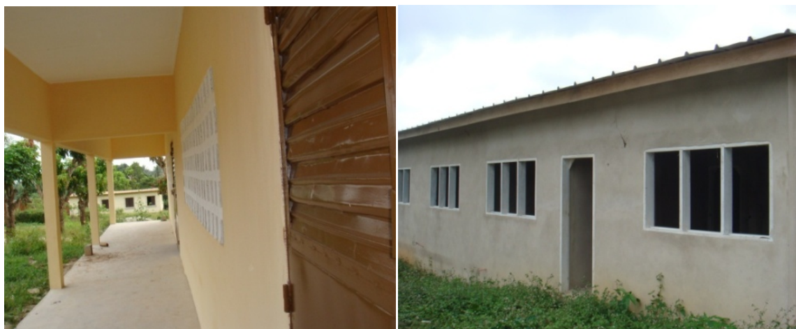
Figure 2 : Construction de salles de classe par le conseil municipal au quartier Lycée
